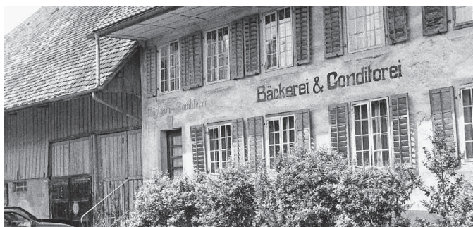
Lange beherbergte das Dubach-Haus die Bäckerei und Conditorei. Jetzt entstehen hier Wohnungen. Auch die Scheune (links) soll neuen Nutzen bekommen.
