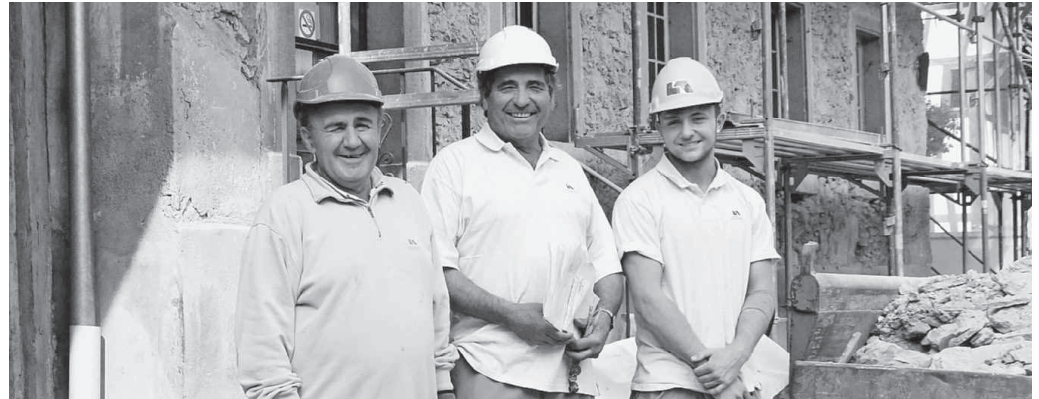
Arbeiten an den alten Gemäuern des Dubach-Hauses: Zek Berisha (links) ist seit 30 Jahren bei René Landolt (Mitte) angestellt, rechts Remy Staub, 1. Lehrjahr.
